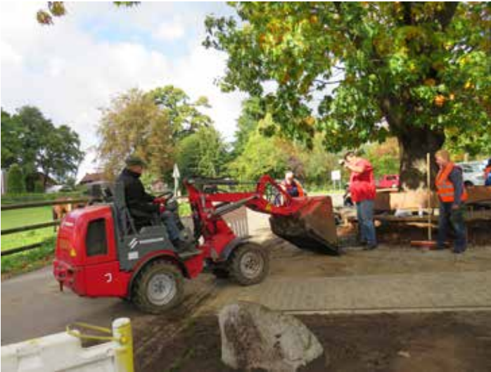
Vor der Gymnastikhalle wird auch alles neu gemacht.
