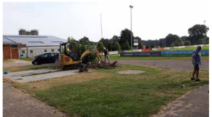
Das Erntefestkomitee verlegt neue Stromkabel
